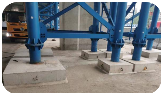
混凝土预制基础
