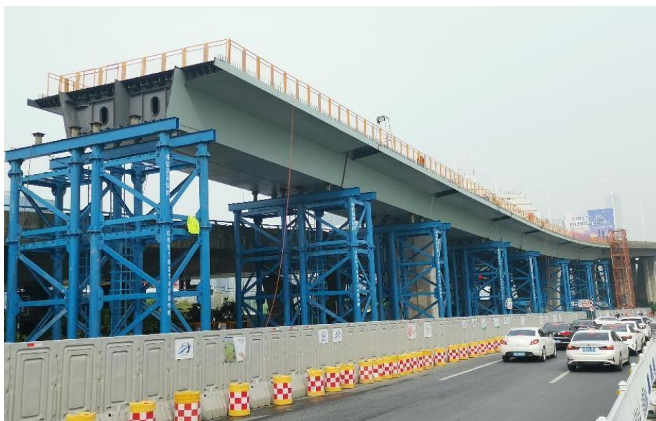
图 11.3-1 南京机场二通道钢桥梁架设现场
