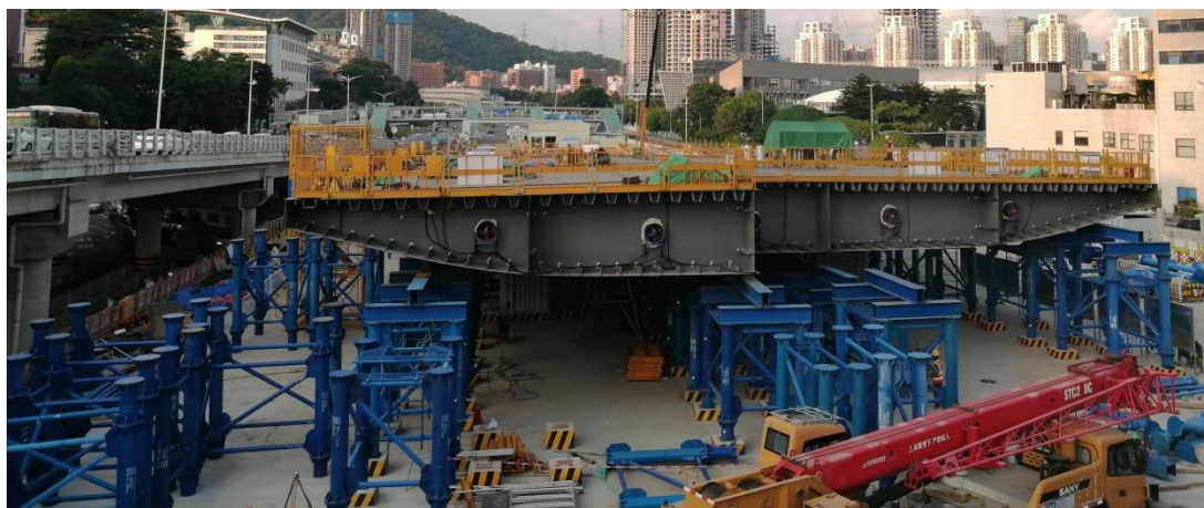
图 11.2-1 深圳黄木岗桥架设现场
