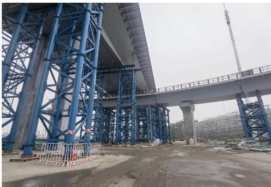
图 11.5-1 包公大道高架桥项目现场
