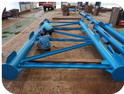
b) 单片桁架组装
