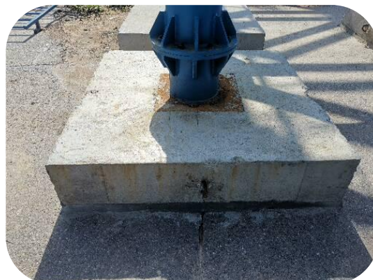
混凝土预制基础及柱底调节段
