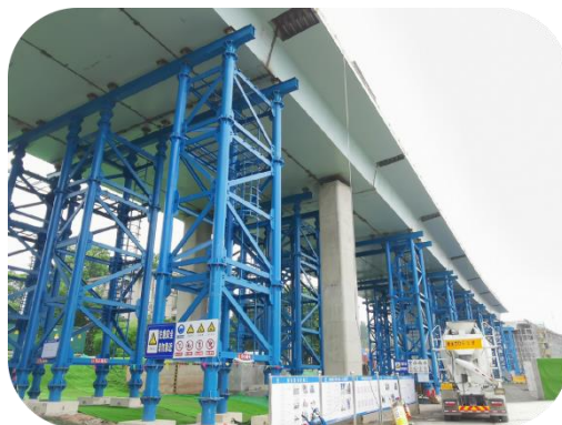
图 5.2-5 支架安装完成图
